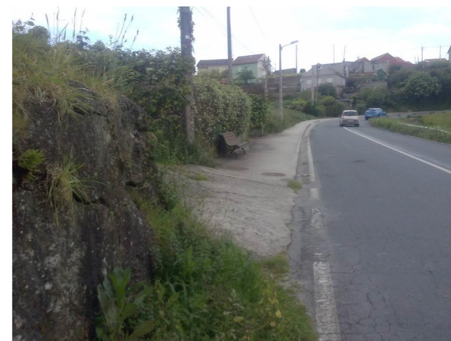
Final de proyecto. Conexión con acera existente
