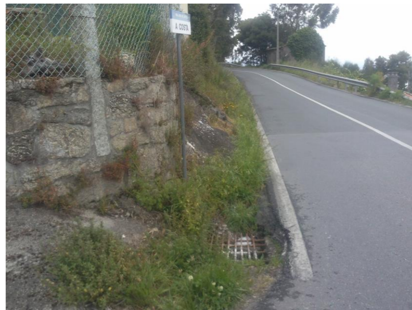
Pk 2+540. Conexión con OTDL existente y adecuación de arqueta
