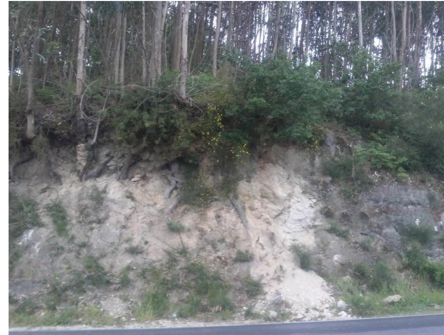
Vista frontal del talud de la curva entre pk 2+580 y 2+660
