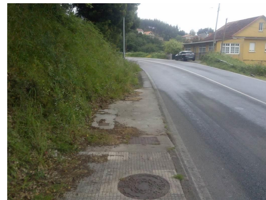
Inicio de proyecto. Final de acera existente
