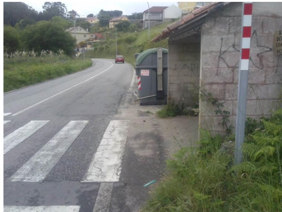
Parada de bus y marquesina actual en margen izquierda. Visita hacia -pk
