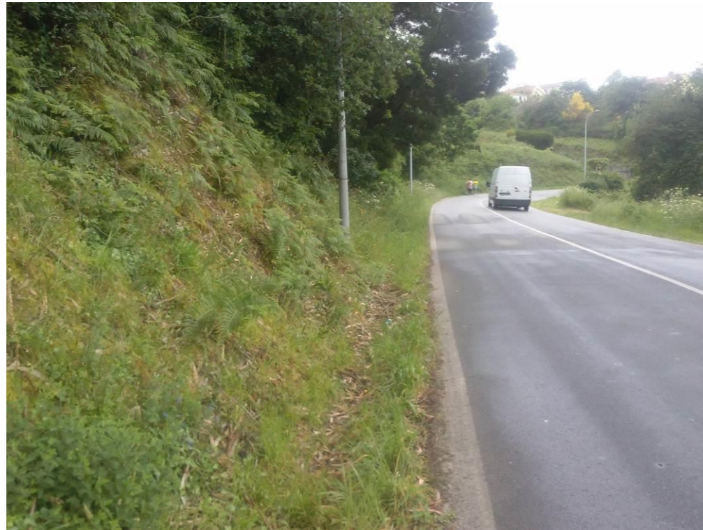
Vista general del tramo de ejecución de la nueva acera. Reperfilados y desmontes localizados
