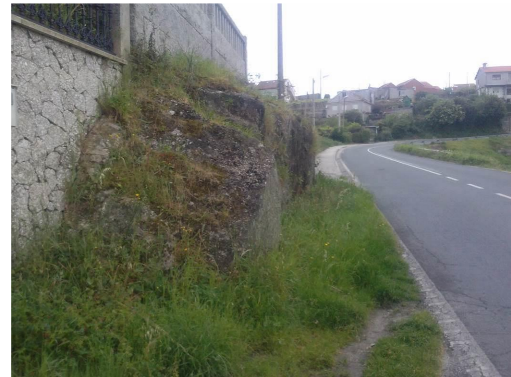
Pk 2+740. Excavación controlada en roca mediante cemento expansivo
