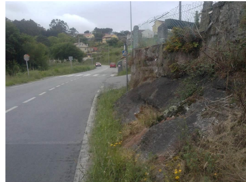
Pk 2+550. Excavación controlada en roca mediante cemento expansivo
